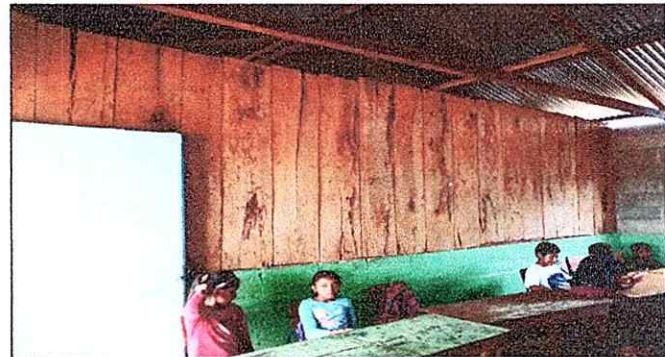
Foto 4: SUSTITUCION DE PARED DE MADERA POR PAREDE DE BLOCK.
