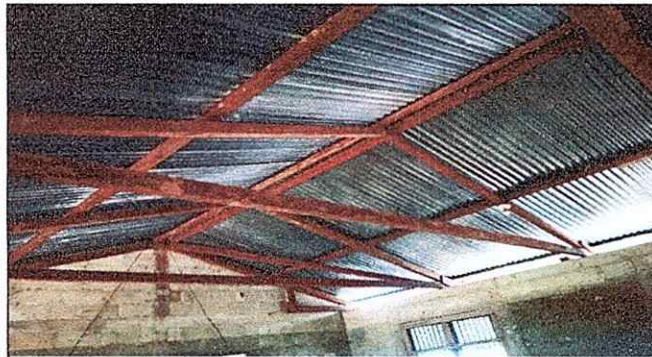
Foto 3: SUSTITUCION DE ESTRUCTURA DE TECHO.
