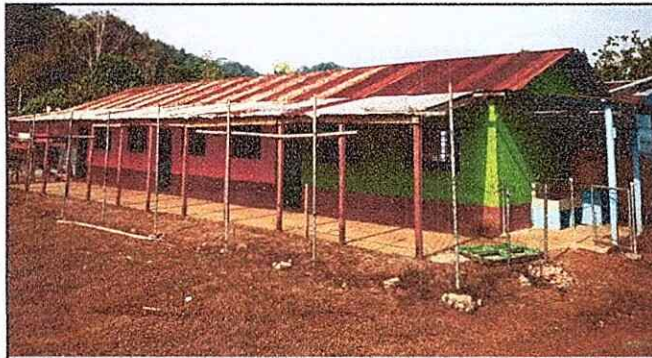
Foto1: SUSTITUCION DECUBIERTA DE LAMINAS.
